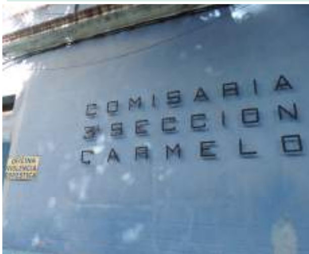
Fachada de Comisaría 3ª de Carmelo. Registro fotográfico MNP 2017.
