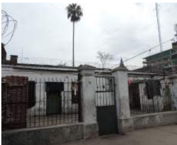
Ingreso a módulo de Unidad 26, Cárcel de Tacuarembó. Registro fotográfico MNP 2017.
